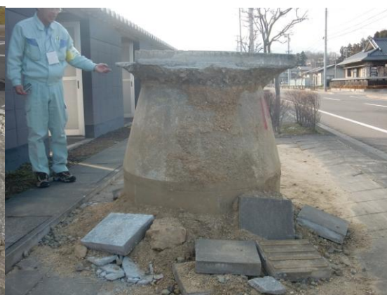
4月1日 白石市での管渠一次調査状況
