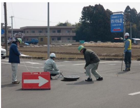
3月31日 亶理町での管渠一次調査状況
