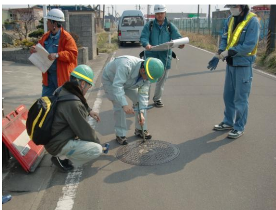
3月30日 亶理町での管渠一次調査状況
