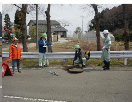
3月31日 亶理町での管渠一次調査状況
