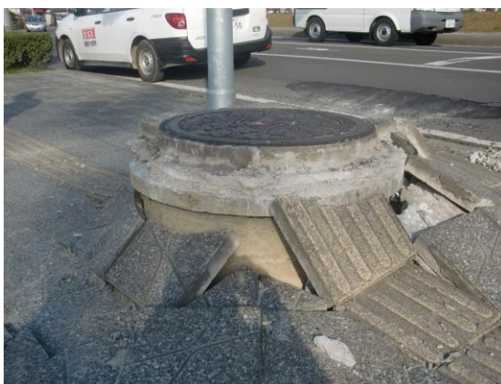
4月1日 白石市での管渠一次調査状況
