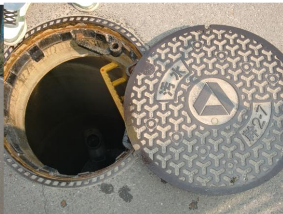
3月30日 亶理町での管渠一次調査状況
