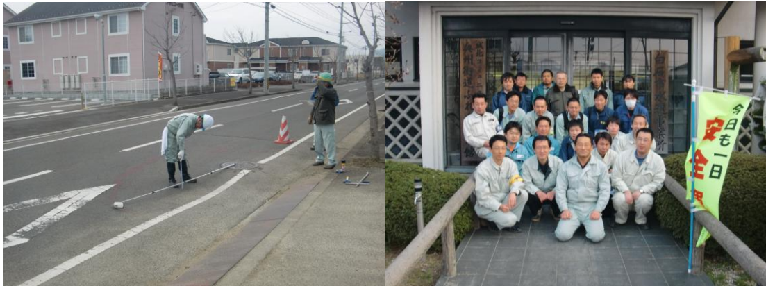
4月2日 白石市での管渠一次調査状況
