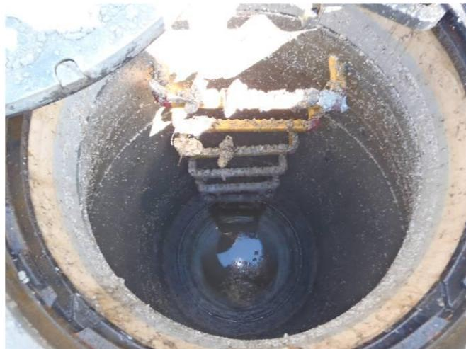
図4-3 津波による浸水箇所のマンホール（沿岸部）
